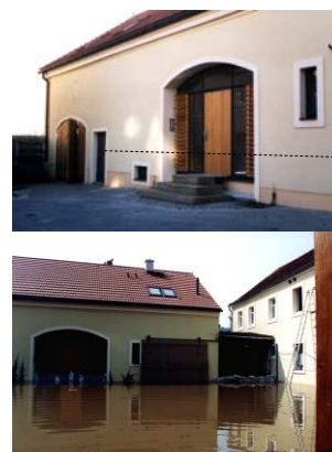
Bild 1 & 2: Hofsituation vor und während des Hochwassers
